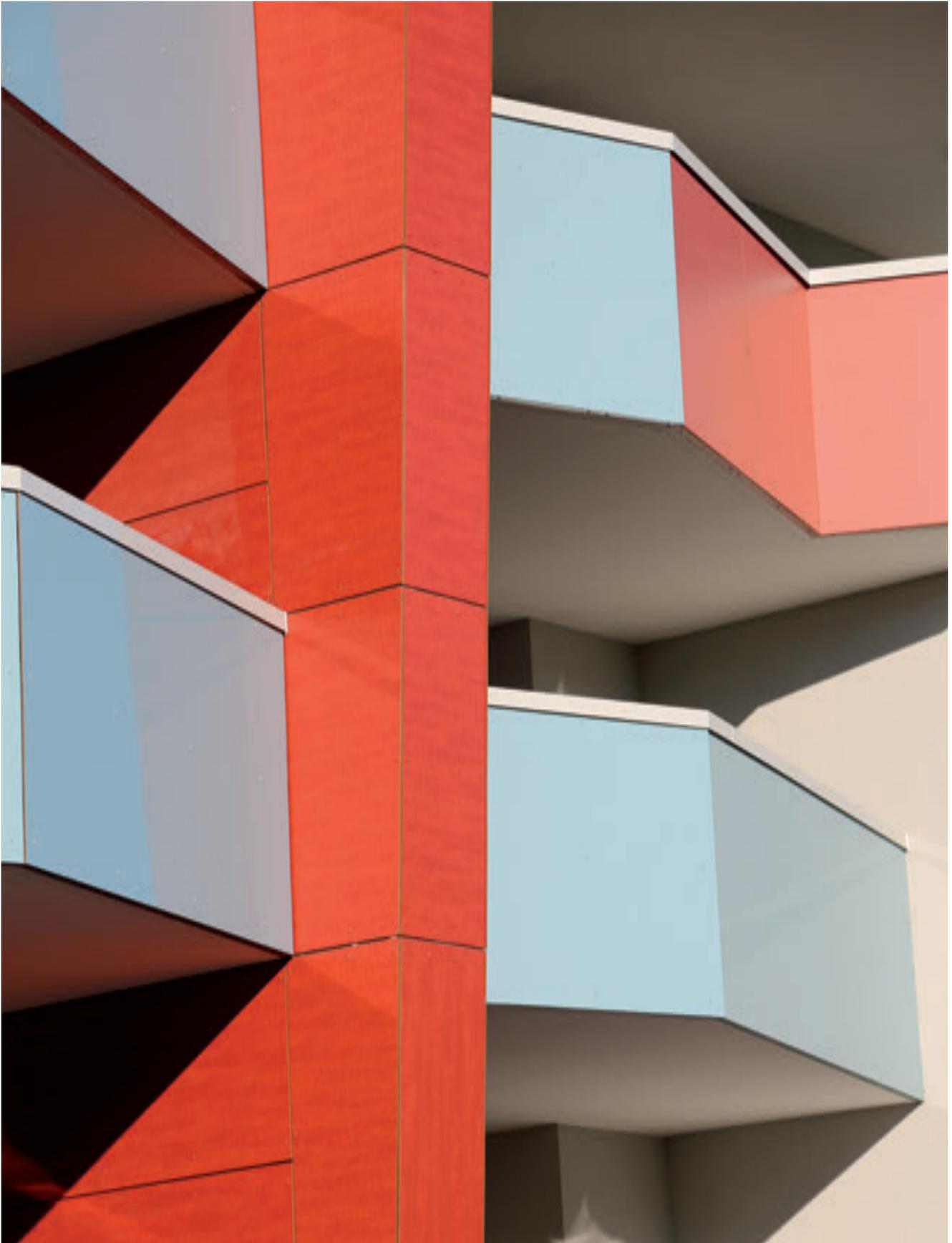
Le bâtiment est en structure béton, nous avons opté pour une isolation par l'extérieur pour traiter les ponts thermiques et, pour la protéger, nous l'avons recouverte de panneaux décoratifs stratifiés garantis 30 ans. Ils ont pour intérêt, outre leur côté esthétique, d'être résistants aux chocs et d'éviter les ravalements répétitifs.
